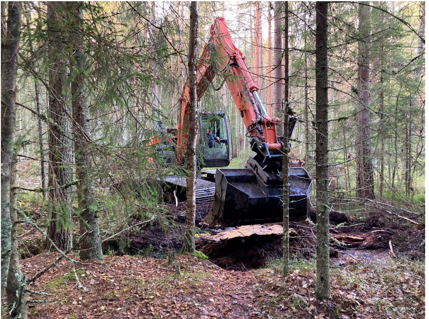
Kuva 6. Suon ojien patoamista Laajavuoressa.
